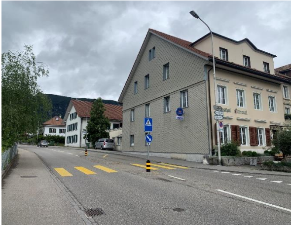
Abbildung 4: Der Strassenraum im Dorfkern von Langendorf gegenüber des Gestaltungsplanperimeters mit städtebaulich relevanter Ost-West-Ausrichtung der Dachfirste, Quelle Foto: Planteam S AG, 13.07.2021.
