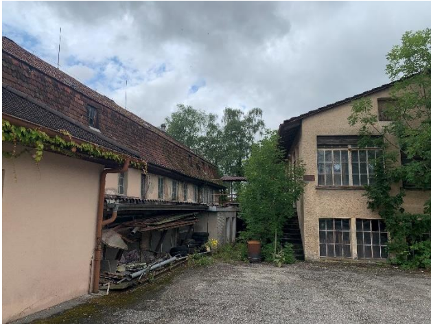
Abbildung 7: Ehemalige Haupt- und Nebenbauten auf der Parzelle GB Nr. 661 vor deren Rückbau, Quelle Foto: Planteam S AG, 13.07.2021.
