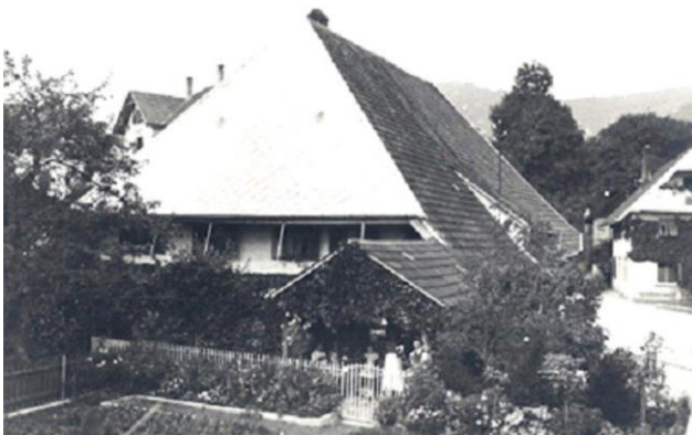
Abbildung 9: Südostfassade der Baute Frauchiger zwischen 1904 und 1914 mit Schindeldach, noch nicht elektrifiziert, Quelle Foto: Persönliches Archiv Urs Frauchiger.
