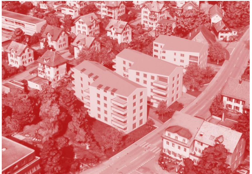
Abbildung: Ansicht der Überbauung gemäss Richtprojekt mit Balkonen und Loggien von Südosten, Quelle: Nomoko AG.
