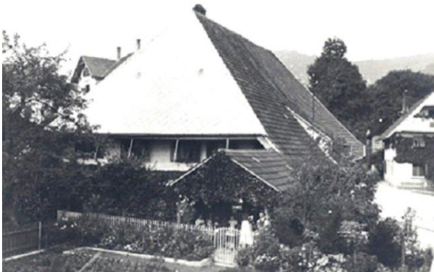
Abbildung 9: Südostfassade der Baute Frauchiger zwischen 1904 und 1914 mit Schindeldach, noch nicht elektrifiziert, Quelle Foto: Persönliches Archiv Urs Frauchiger.
