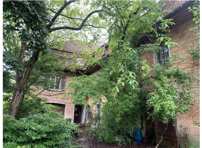
Abbildung 8: Ehemalige Hauptbaute auf der Parzelle GB Nr. 661 vor deren Rückbau, Quelle Foto: Planteam S AG, 13.07.2021.
